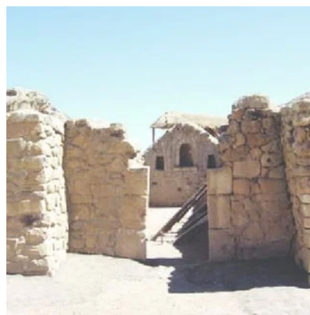
Fig. 4. Sitio prehispánico en territorio Canas , alto Apurímac (Cuzco, Perú), intervenido por los españoles con la construcción de una capilla cristiana con arquitectura estilo inca: capilla de Mauk'allaqta. (Copyright M. Arenas, fig. 3, 2016, p. 65) 13 .
